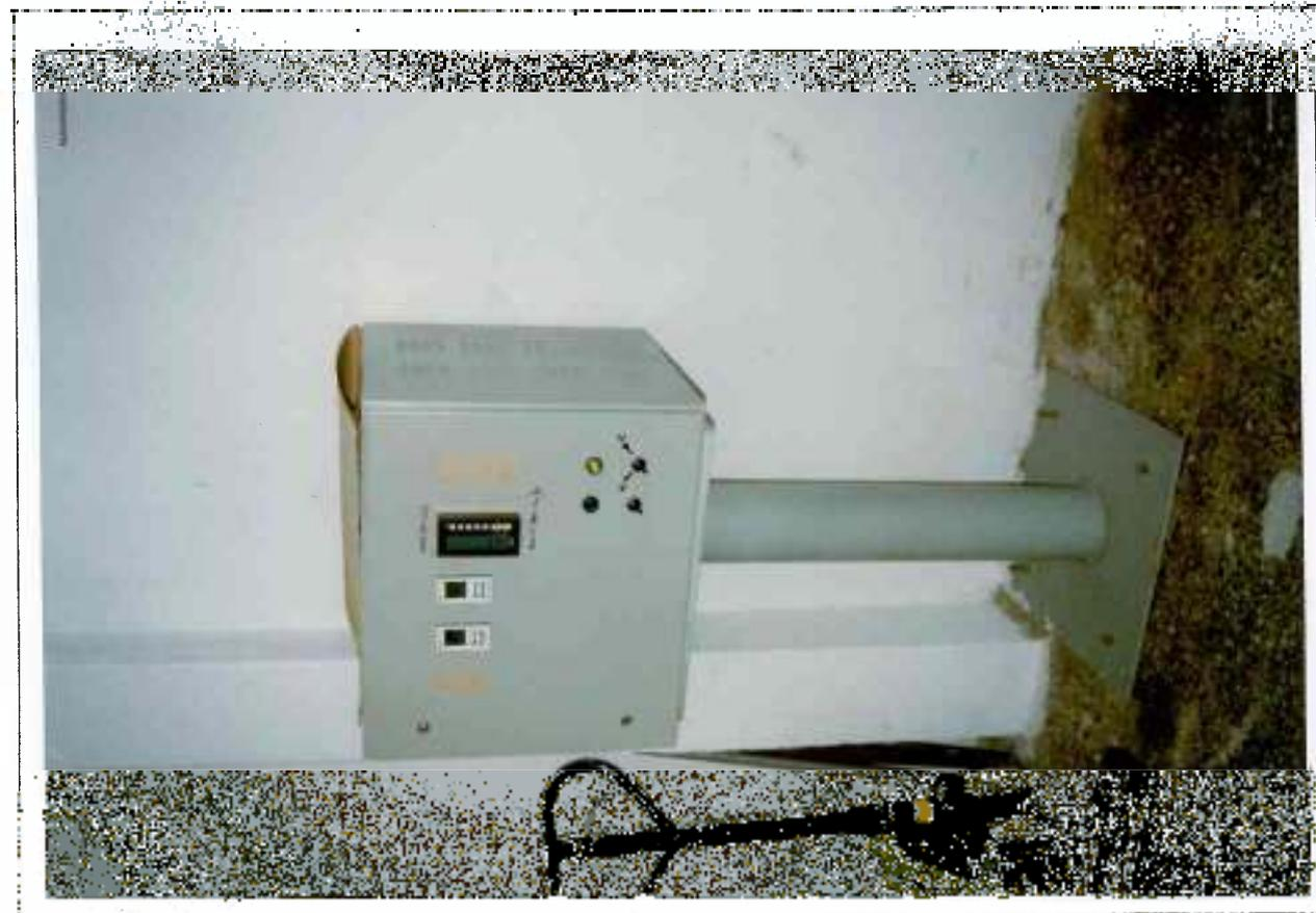
FOTO N°:57 DESCRIZIONE: PULPITO CONTROLLO IMPIANTO VAPORE
