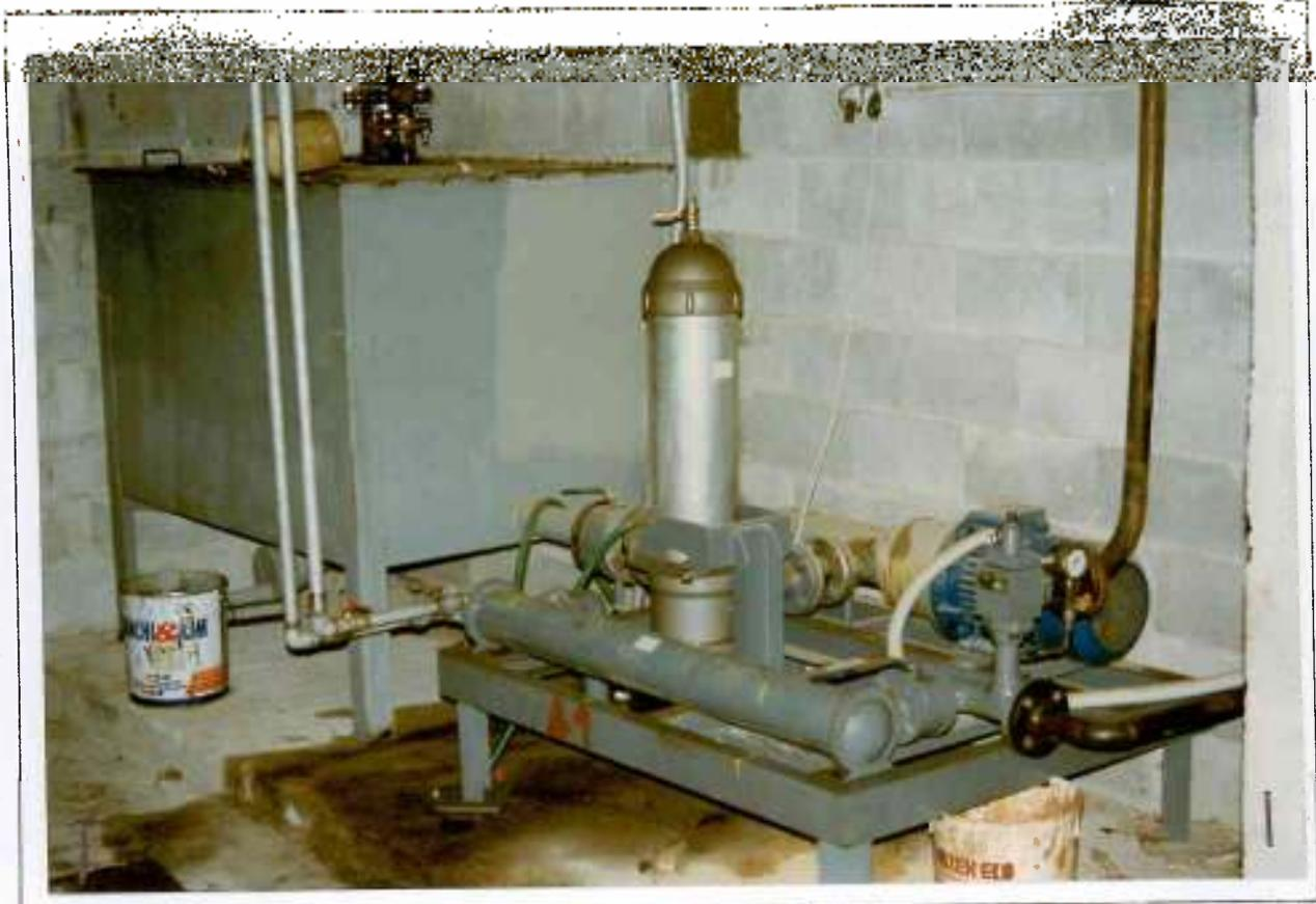
FOTO N°: 46 DESCRIZIONE: IMPIANTO LUBRIFICAZIONE
